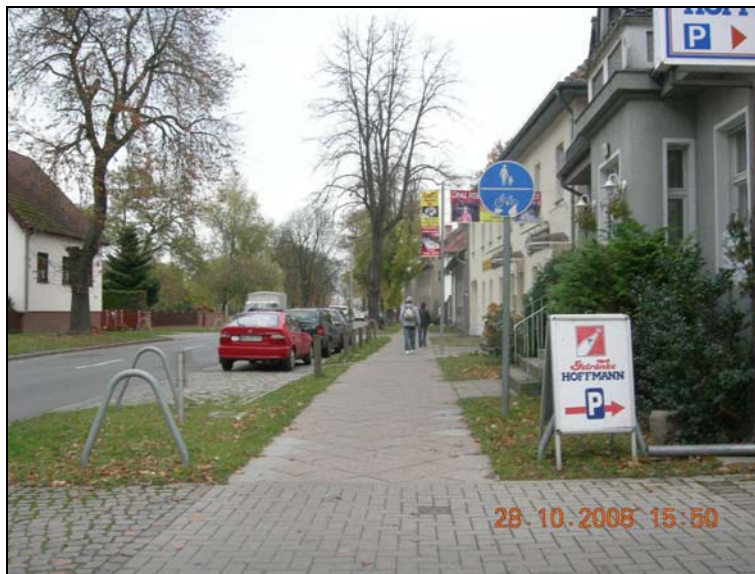
Abbildung 1-17: Gemeinsamer Geh- und Radweg, Carl-Schmücke-Straße
