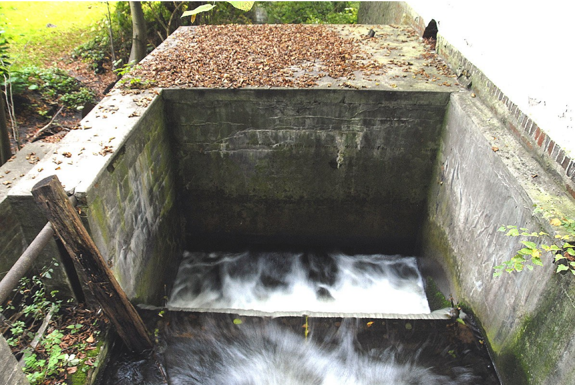
1281_0001_b Fredersdorfer Mühlenfließ bei Spitzmühle, stromabwärts
